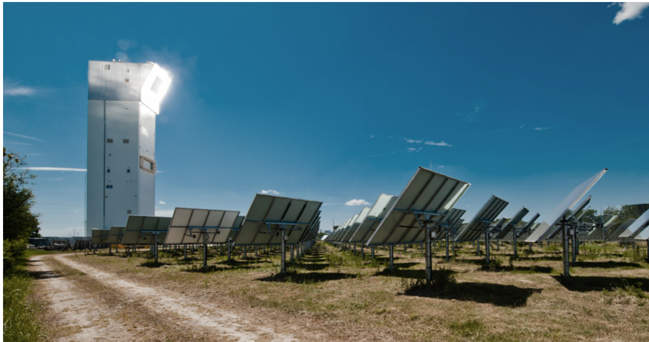
Typischer Aufbau eines Heliostatenfeldes
